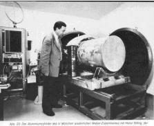
Abb. 23: Der Alluminiumzylinder des in München wiederholten Weber-Experimentes im Heinz Billing, der den Versichsaubau keten. Der Zylinder hängt an einem Stahtantt. Deutlich zu sehen ist die Isolation gegen mechnische Eschlitterungen, bestehend zus aberechseinden Eigen von Eisem und Gummi. Im Hintergrund der Vakuumtank und die Elektronik mit einer Antenne für Zeitzeichen.
